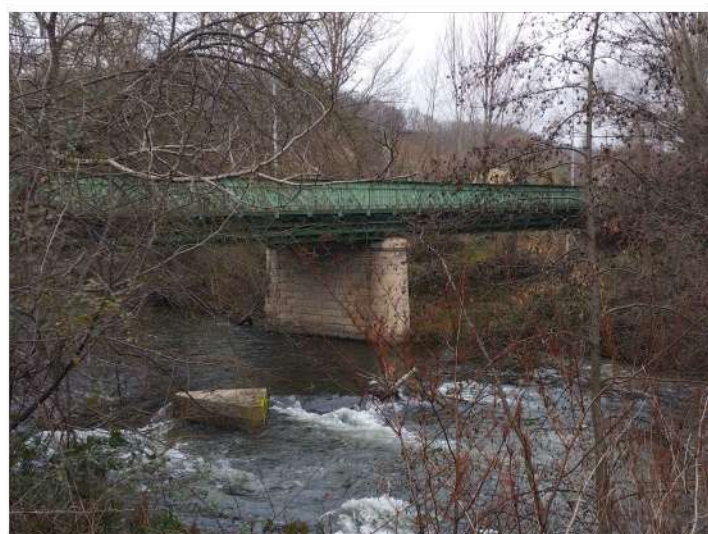
Le pont route d'Escosse (Pamiers) Cliché Mairie du Vernet d'Ariège
